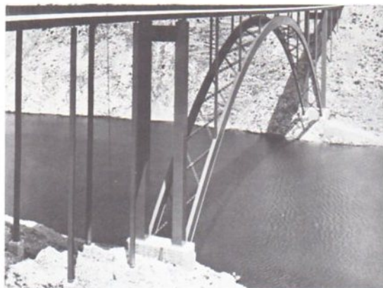
Abb. 110 Bogenbrücke mit obenliegender Fahrbahn (die selbst einen Verband darstellt). Es handelt sich um die Bogenbrücke in der Küstenstraße bei Zadar (Jugoslawien), bei der ein reiner Rautenverband vorliegt.
