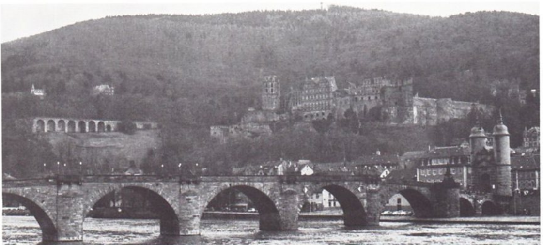
Abb. 99 Die alte Brücke in Heidelberg. Massivbauweise mit mehreren gegeneinander abgestützten Bögen. Nur jeweils am äußeren Ende der äußeren Bögen herrscht Horizontalschub.
