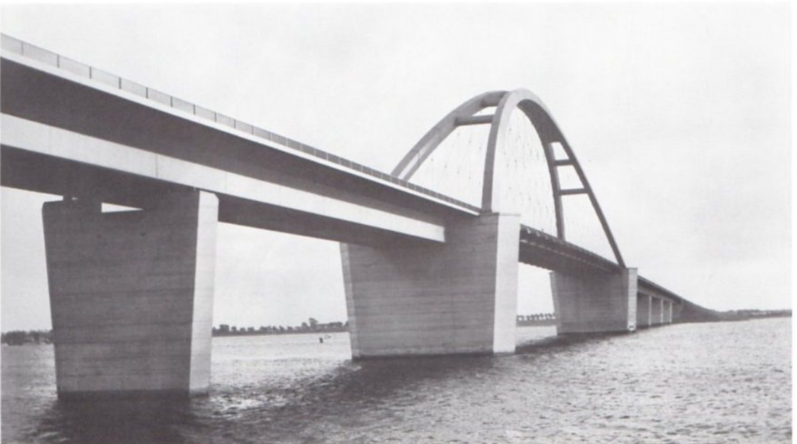
Abb. 113 Gesamtansicht der Fehmarnsundbrücke von der Inselseite aus aufgenommen. Hier sind deutlich die an die bogenüberspannte Schiffsfahrtsöffnung anschließenden Felder der Durchlaufräger (torsionssteife Kästen), die Balkenbrückenteile zu erkennen.
