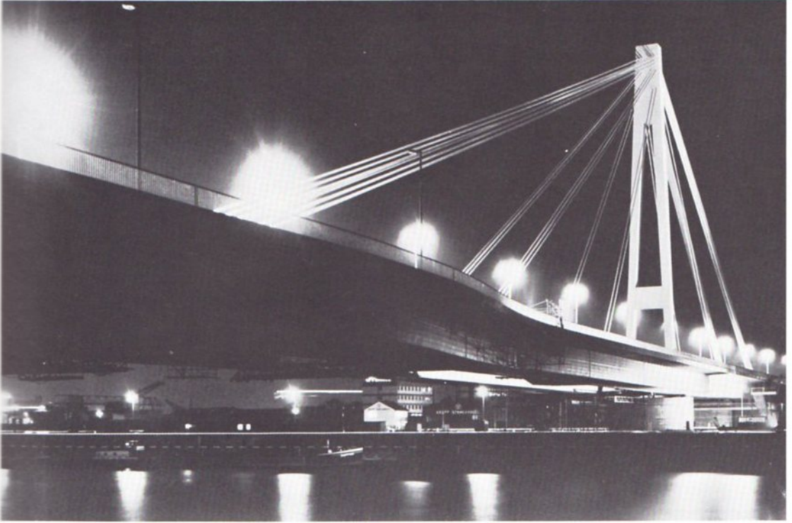
Abb. 92 Von der Ludwigshafener Seite aus aufgenommen, ist die Grundrißverbreiterung gut erkennbar. Der auf der Mannheimer Seite stehende 84 m hohe Pylon übernimmt das Gewicht des 290 m weit gespannten Feldes über dem Rhein. Die Schrägseile führen die Last zum sehr schlanken A-förmigen Pylonen (Mittelträgeranordnung), der in den rechtsrheinischen Spannbeton-Brückenteilen rückverankert ist. Die sehr schlanke Ausführung des Pylons paßt sich sehr gut der Hafen- und Industrielandschaft an, auch wirkt die Brücke trotz ihrer breiten Anlage sehr grazil (Schlankheitsgrad von Höhe zu Länge = 1 : 65).
