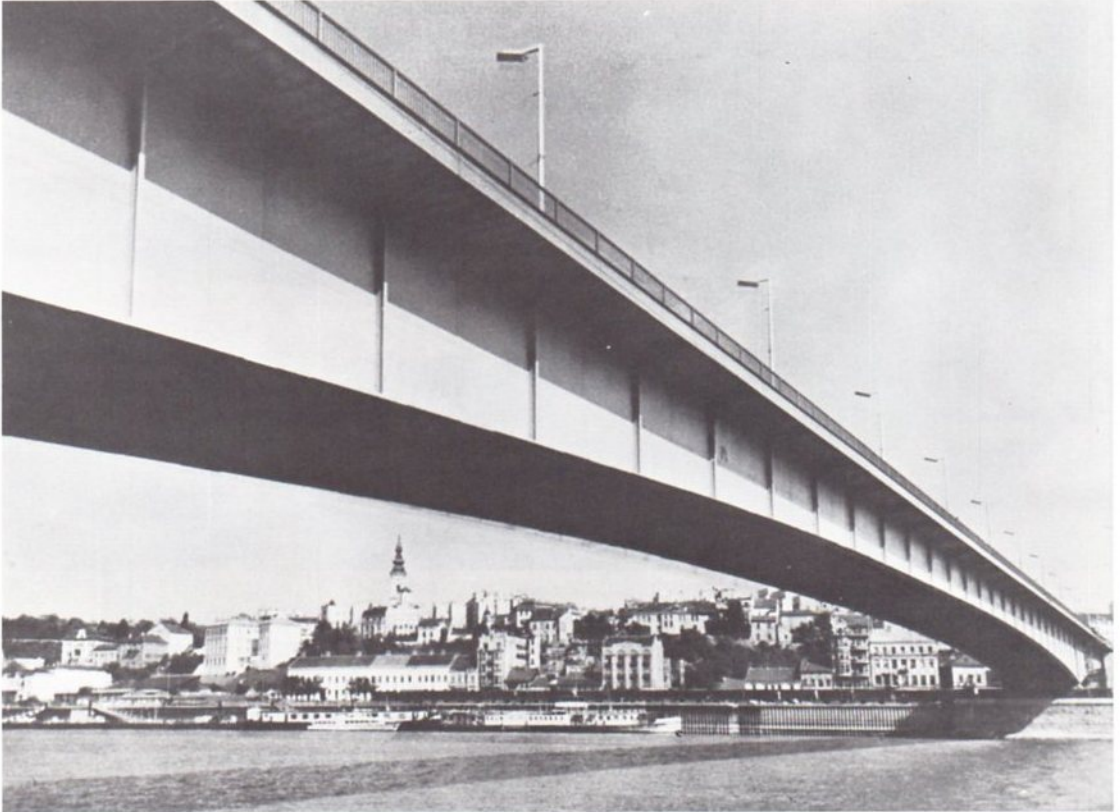
Abb. 52 Weitestgespannte Vollwand-Durchlaufträger-Brücke (Deckbrücke) über die Save in Belgrad. Die 1956 von deutschen Ingenieuren entwickelte Brücke hat eine Stützweite von 261 m in der Mittelöffnung.
