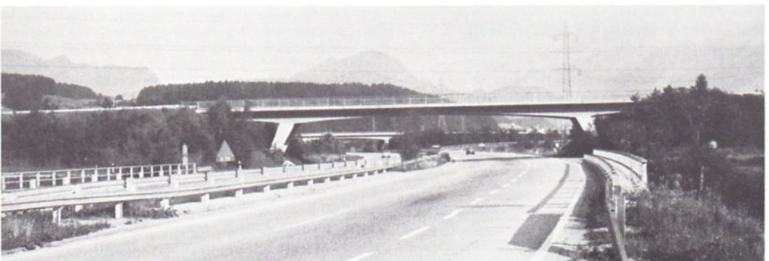
Abb. 107 Rahmenbrücke mit schräggestellten Stielen über die Autobahn bei Hallein in Österreich.
