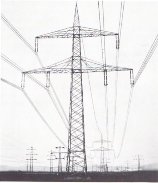
Abb. 289 Beispiel für fest in Fundamente eingespannte Maste.
