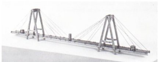
Abb. 212 Modell einer Schrägseilbrücke mit 2 Pylonen. – Gemeinschaftsarbeit aus vier u-t S und vier u-t 1.
