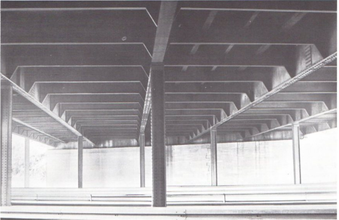
Abb. 142 Längs- und Querträger der Brücke über die Autobahn zwischen Karlsruhe und Durlach.
