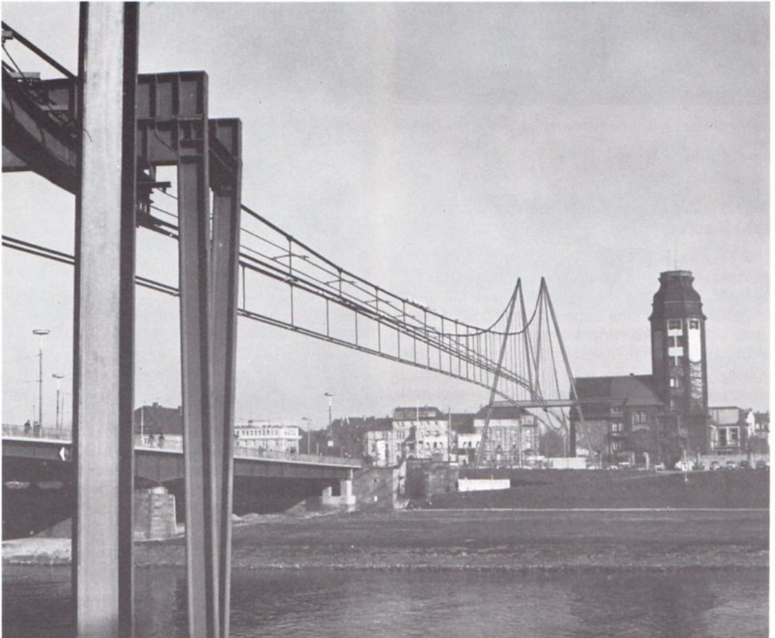
Abb. 295 Neckarüberspannung der im Bau befindlichen Airbus-Bahn neben der Kurpfalzbrücke in Mannheim. Die Konstruktion der „Schienenstrecke“ ist nach dem Tragsystem der Hängebrücke gestaltet.
