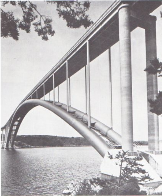
Abb. 103 Brücke über den Askeröfjord in Schweden. Ausführung der Stützbogen in Stahlrundprofilen mit einem Durchmesser von 3,8 m.
