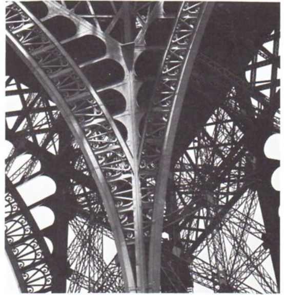
Abb. 286 Fachwerkdetails vom Eiffelturm in Paris.
