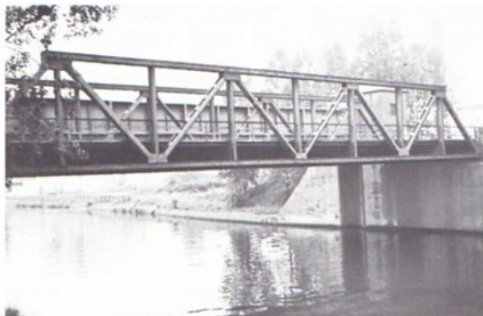
Abb. 220 Fachwerkbrücke über den Neckarkanal bei Ladenburg.
