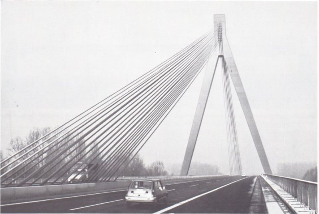
Abb. 240 Schrägseilbrücke über den Rhein bei Speyer (Autobahnbrücke).
