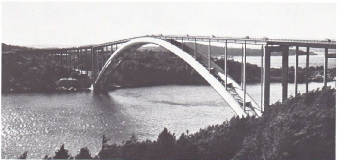
Abb. 231 Straßenbrücke über den Askeröfjord in Schweden.
