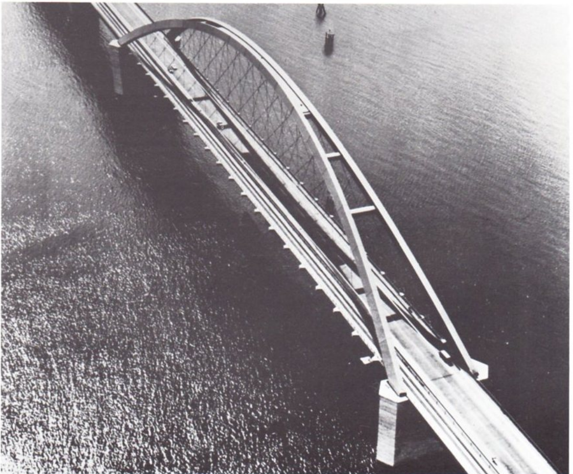
Abb. 114 Luftaufnahme des Bogentragwerks der Fehmarnsundbrücke. Diese Aufnahme zeigt auch sehr anschaulich die kreuzweise verlaufenden, untereinander mit Spannschlössern verbundenen, vorgespannten Hänger. Da die Brücke einseitig auch für den Eisenbahnverkehr konzipiert wurde, sind die auf dieser Seite verwendeten Hänger etwas stärker dimensioniert.
