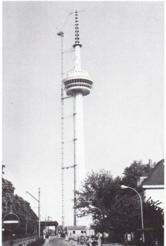
Abb. 287 Fernmeldeturm in Mannheim, Höhe 204,70 m. Typisches Beispiel für die heutige Stahl-Beton-Bauweise, bei der ein Kletterkran bis fast auf die gesamte Bauhöhe hochklettert und alle Baumaterialien anhebt.
