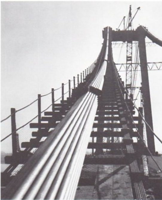
Abb. 117 Kabelmontage der 1965 erbauten Rheinbrücke Emmerich-Kleve. Im Hintergrund erkennt man oben die Kabelsattelager auf dem Pylon, links das aus vielen geschlagenen Seilen bestehende sechseckige, durch provisorische Bindungen zusammengefaßte Kabel, das auf dem Arbeitssteg aufliegt.
