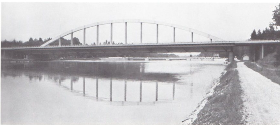
Abb. 98 Gesamtansicht der Autobahnbrücke über die gestaute Salzach südlich von Salzburg.
