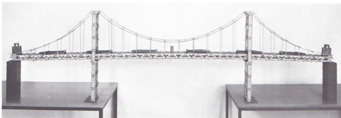
Abb. 237 Großmodell einer in sich verankerten Hängebrücke, das von 3 interessierten Schülern in freiwilliger Ferienarbeit gebaut wurde.
